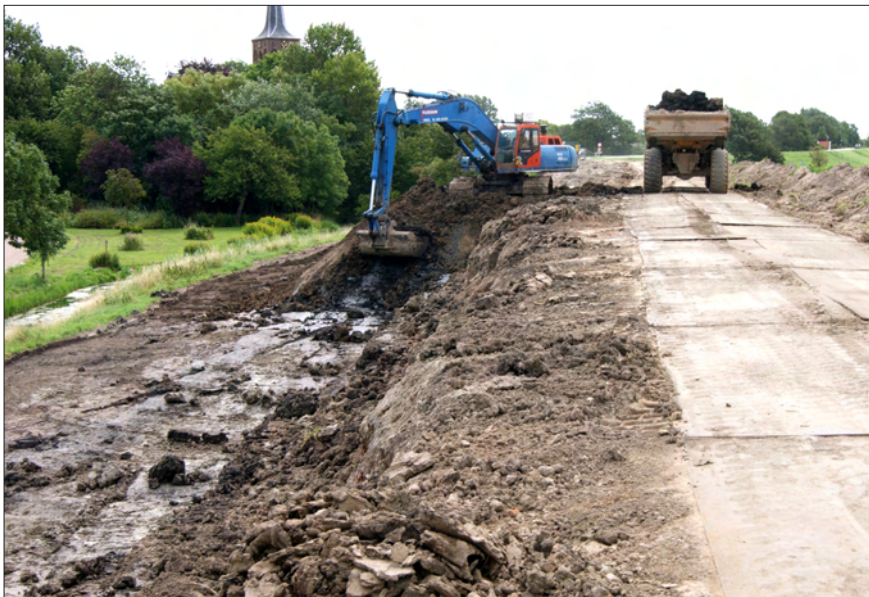
Afbeelding 5.3.34 De ontgravingswerkzaamheden in volle gang. De dumpers rijden over de nieuwe dijk. De dieplepelkraan graaft een groot deel van de oude kern weg.
